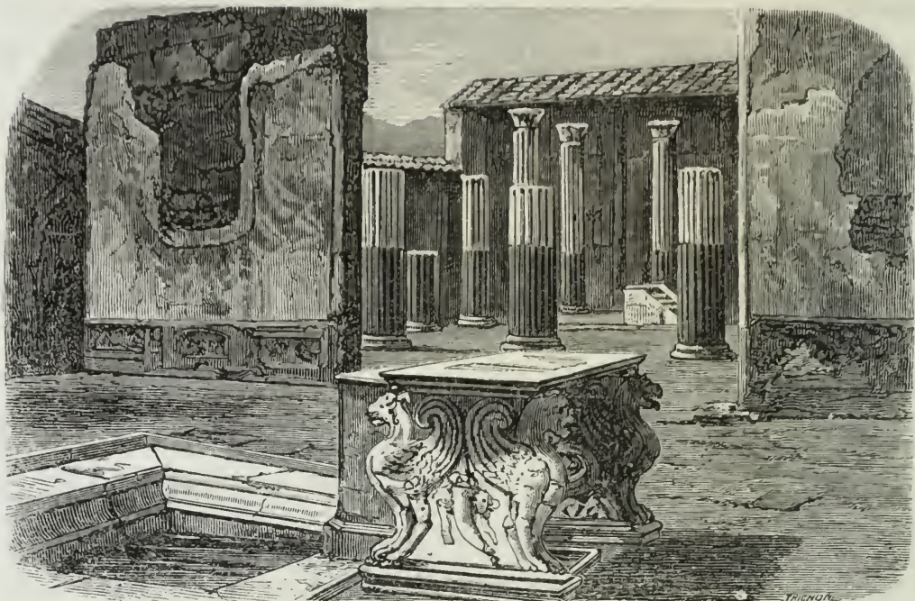
Atrium de la Maison de Méléagre.
